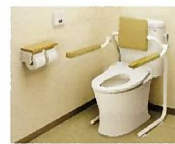
トイレ手すり
